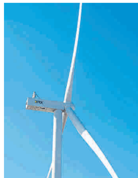
Hay 19 generadores funcionando. Cortesía Dtek
