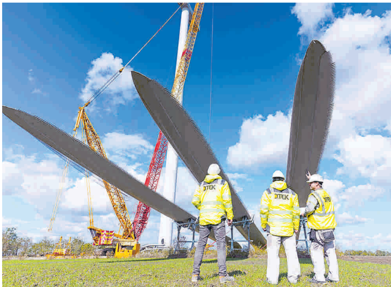
Los obreros de Tyligulska usan chalecos salvavidas en la construcción. Cortesía Dtek
