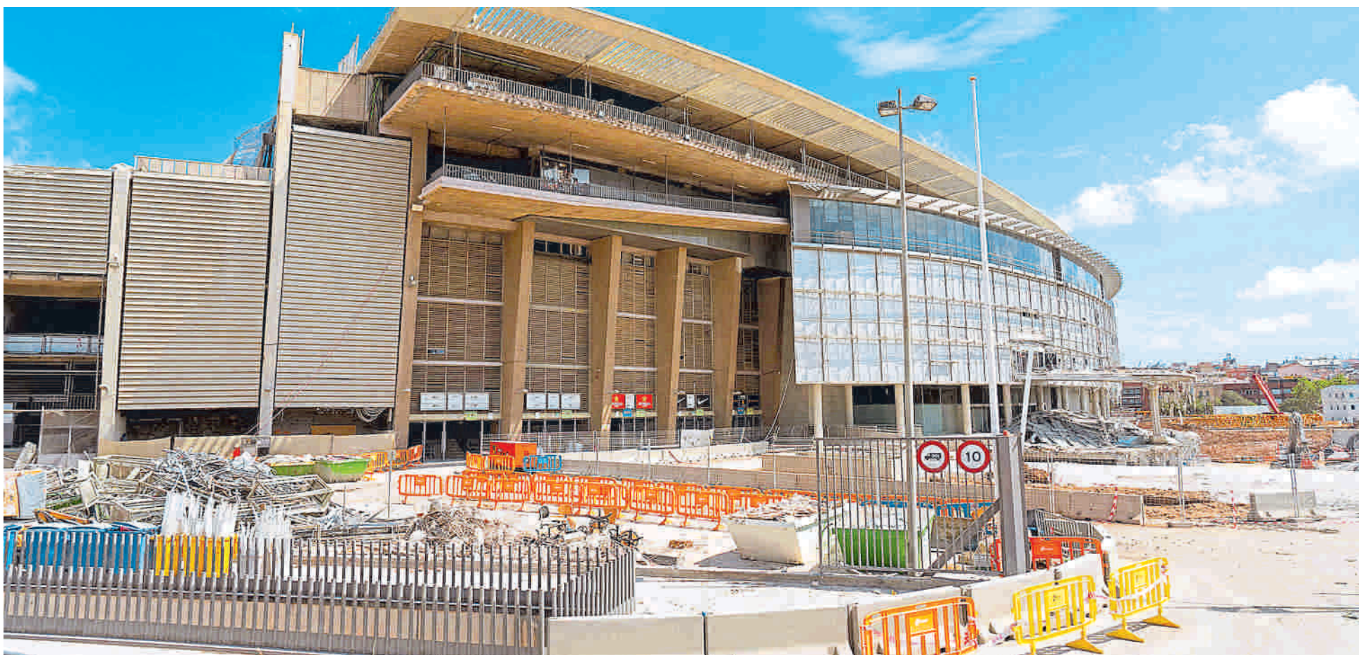
Imagen de cómo avanzan las obras de la entrada del estadio que remodela actualmente el FC Barcelona, con el que busca multiplicar sus ingresos. Foto: iStock
