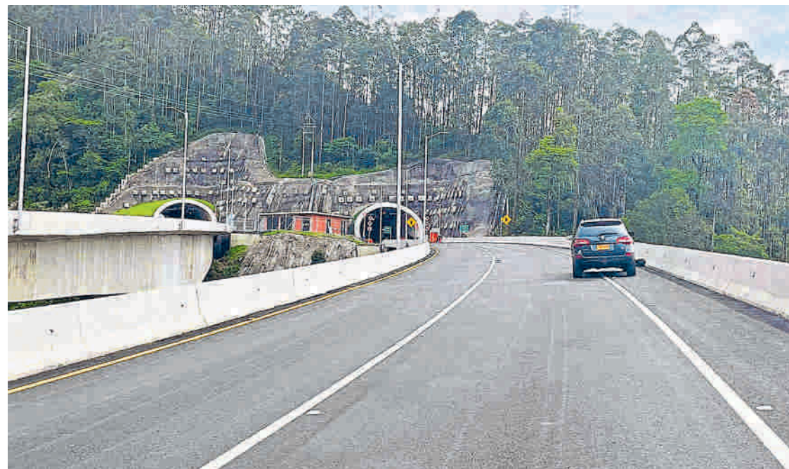
Aspecto de una de las obras viales que componen Pacífico 1. Cortesía
